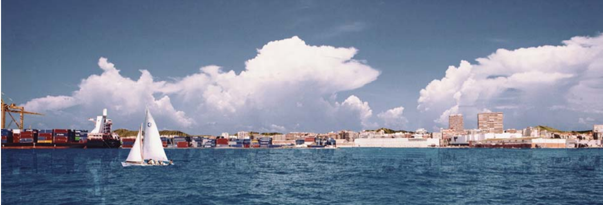
Vista de la situación actual desde la fachada marítima.
